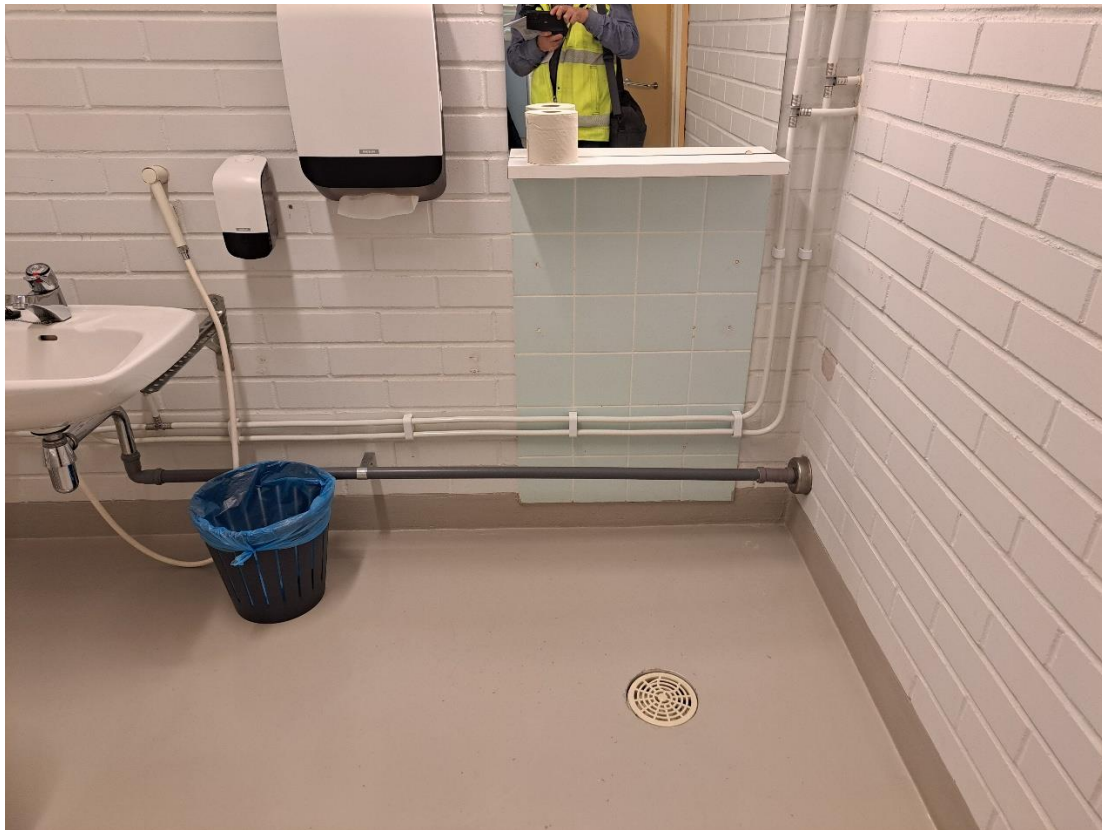
Kuva LVI 4: Uusitut vesijohdot ovat komposiittiputkea
