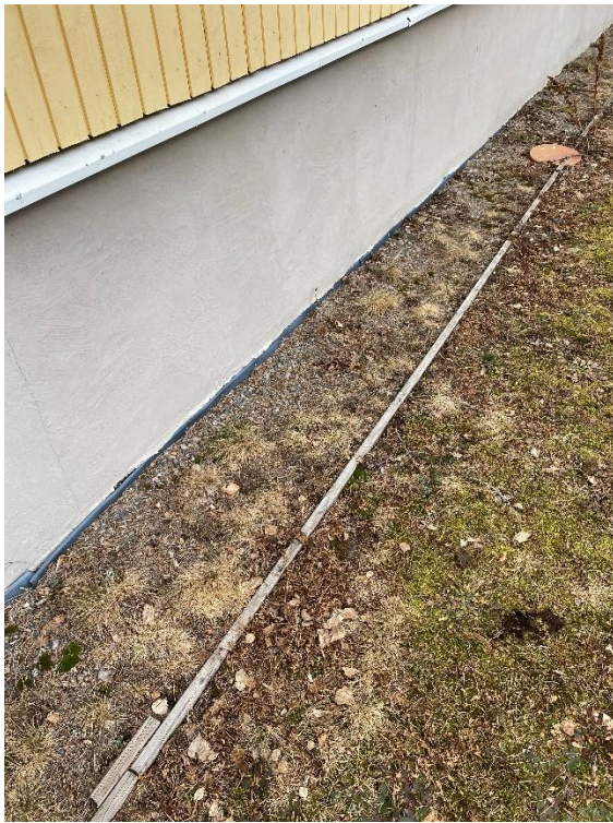
Kuva 9 RAK: Sokkelin vieruskaista ruohottunut
