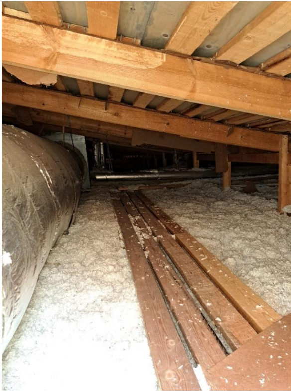
Kuva LVI 11: Poistoilmakanava ullakkotilassa
