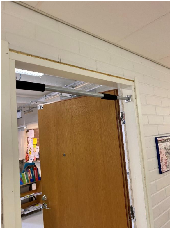
Kuva 36 RAK: OT185; vuorilista puuttuu
