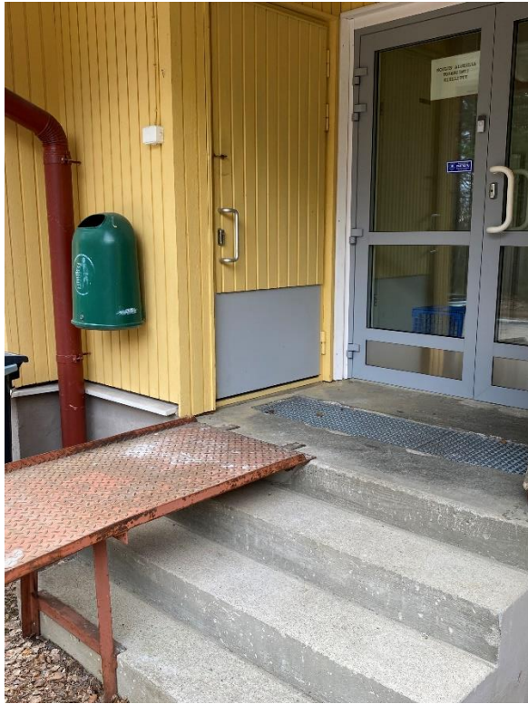
Kuva 13 RAK: Ulko-ovet uusittu
