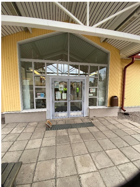
Kuvat 15 ja 16 RAK: Pääsisäänkäynti; laatoitus painunut. Teräsristikoiden maalaus huono
