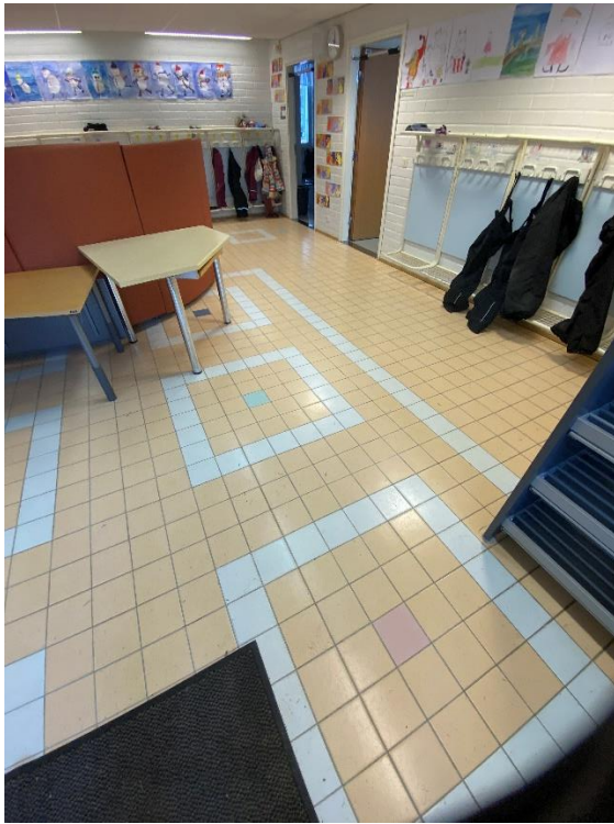
Kuva 17 RAK: Laattalattiat siistit
