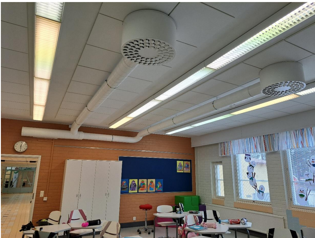
Kuva LVI 10: Luokkahuoneen muutettu tuloilman kanavointi ja uudet tuloilmahajottajat
