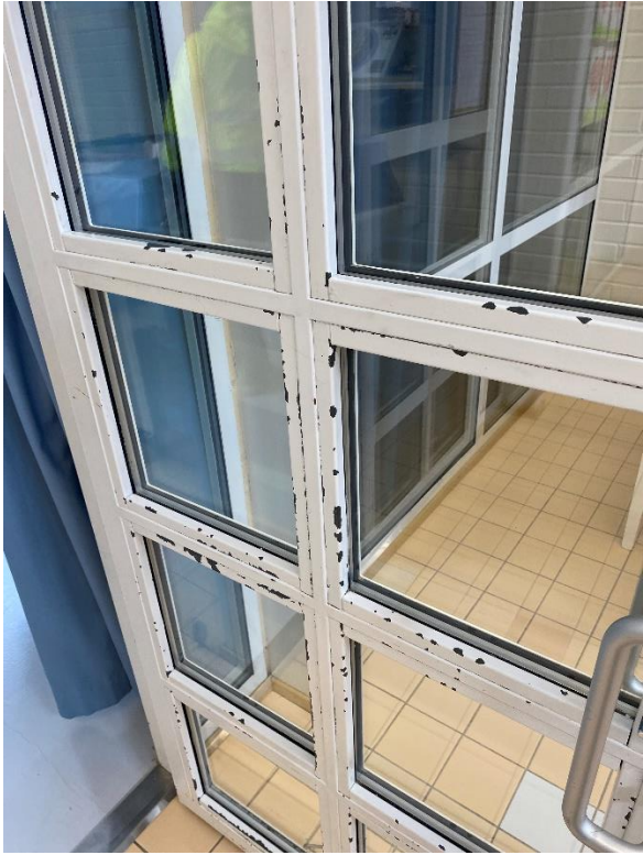
Kuvat 32 ja 33 RAK: Ruokasalista ”kirjastoon”; oven ja metalli-ikkunan huoltomaalaustarve.
