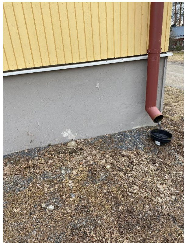
Kuva 6 RAK: Sokkelissa maalauskorjauksia
