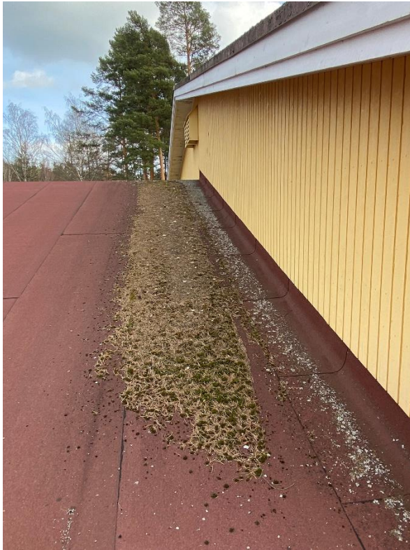
Kuvat 47 ja 48 RAK: Katon puhdistus tarpeen
