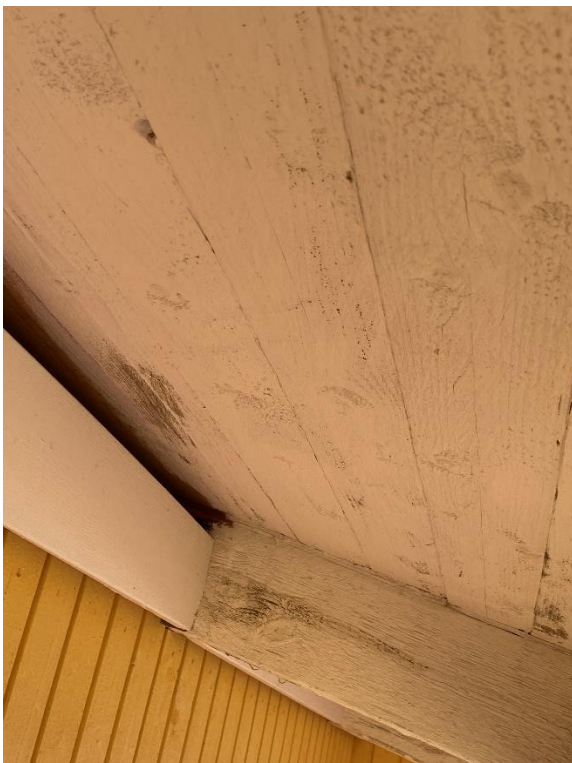
Kuva 42 RAK: Räystään tuuletusrako ok.
