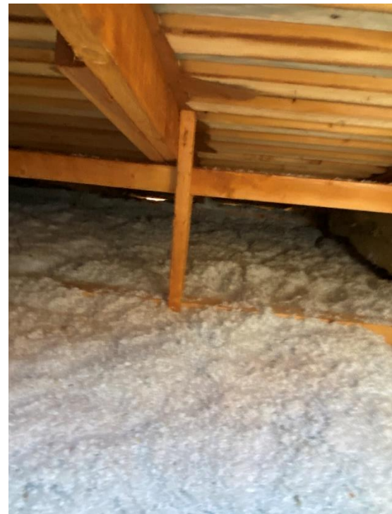
Kuvat 46 ja 47 RAK: Yläpohjan eristeet ja rakenteet näyttivät olevan kunnossa.
