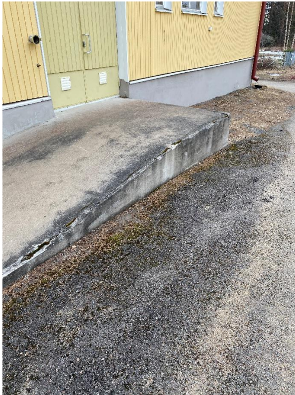
Kuva 5 RAK: Jätetilaan menevä luiska
