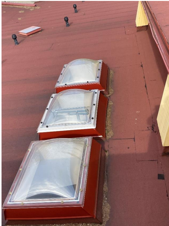
Kuva 44 RAK: Kattoikkunat kunnossa
