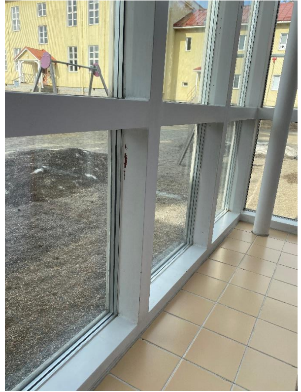
Kuvat 32 ja 33 RAK: Ruokasalista ”kirjastoon”; oven ja metalli-ikkunan huoltomaalaustarve.
