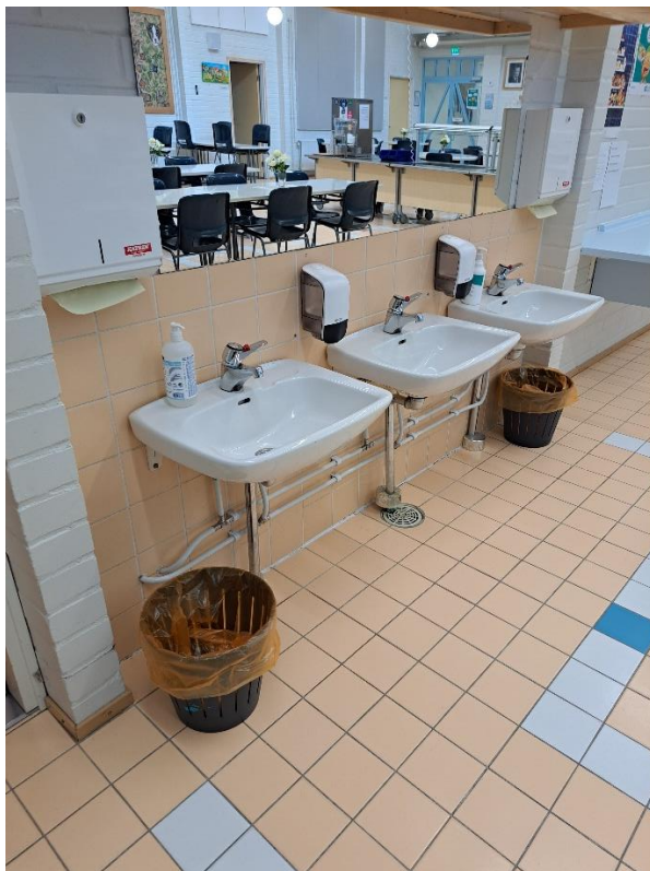
Kuva LVI 5: Vesi- ja viemärikalusteet ovat vielä kohtuullisessa kunnossa
