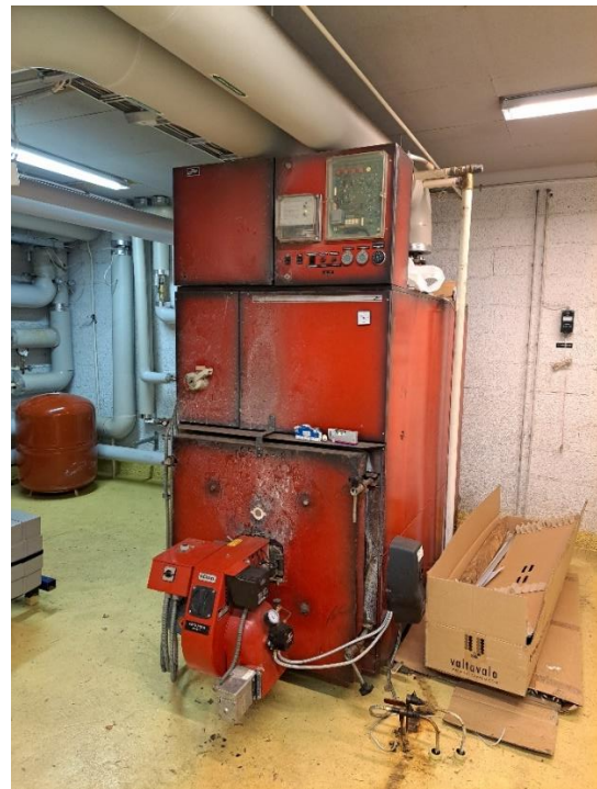
Kuva LVI 2: Öljykäyttöinen varakattila
