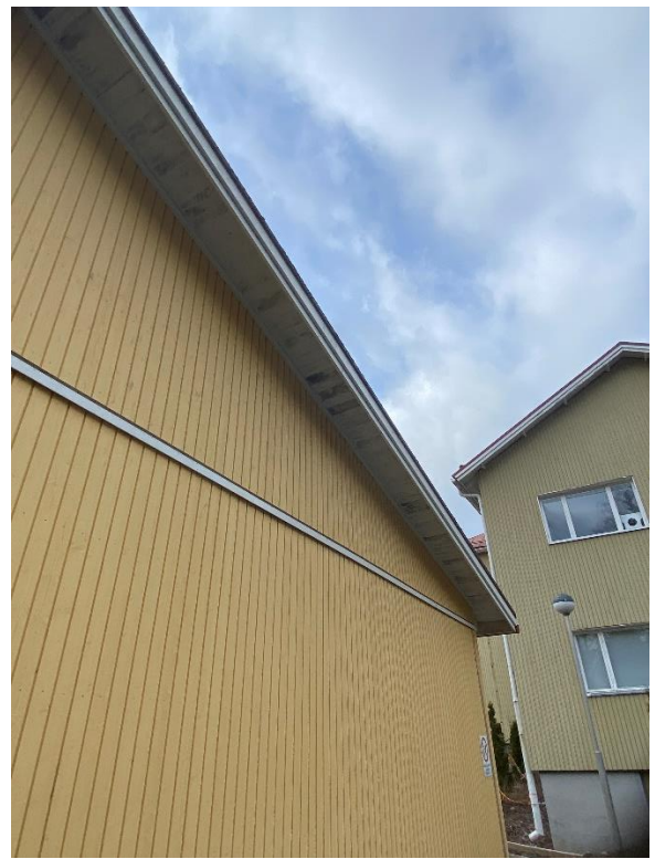
Kuva 14 RAK: Puujulkisivu on siistissä kunnossa
