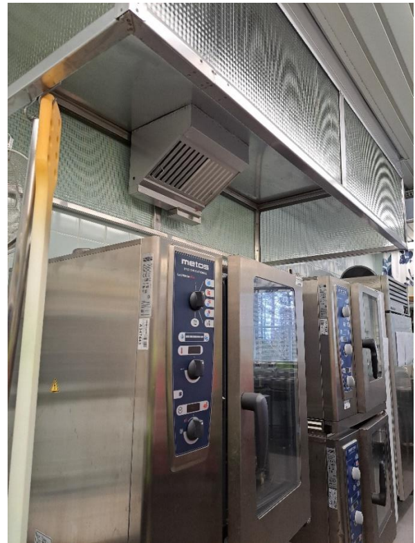
Kuva LVI 12: Keittiön höyryhuuva
