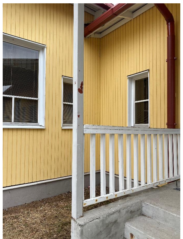
Kuva 3 ja 4 RAK: Keittiön sisäänkäynti; Maalauskorjausta kaiteissa ja pilareissa. Portaiden pinnat ja sokkeli huonossa kunnossa.
