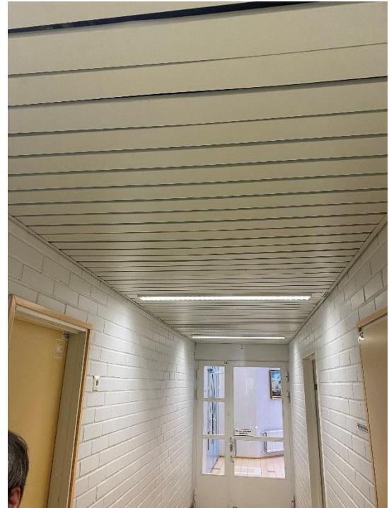
Kuva 25 RAK: Alakatot kunnossa
