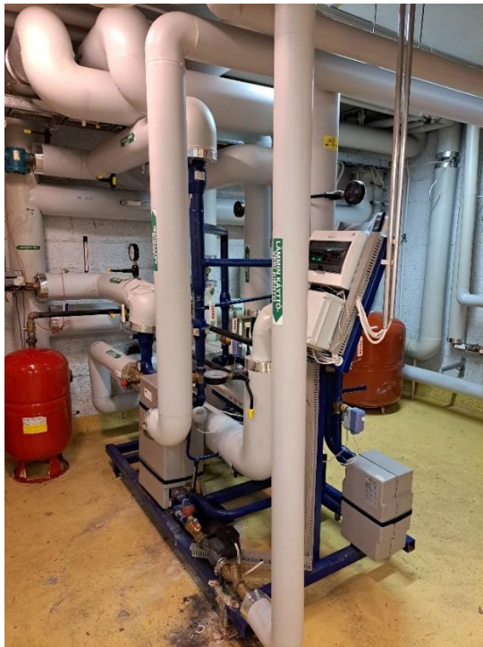
Kuva LVI 1: Kaukolämmön alajakokeskus
