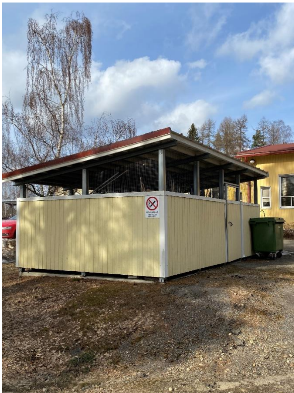
Kuva 38 RAK: Varastokatos kunnossa
