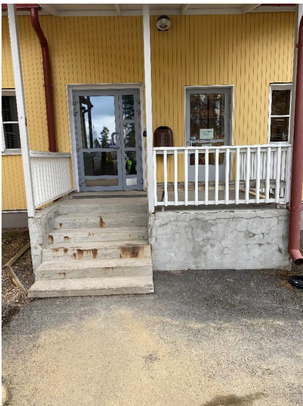
Kuva 3 ja 4 RAK: Keittiön sisäänkäynti; Maalauskorjausta kaiteissa ja pilareissa. Portaiden pinnat ja sokkeli huonossa kunnossa.
